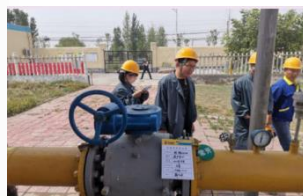
鹤壁公司联合安全检查现场
